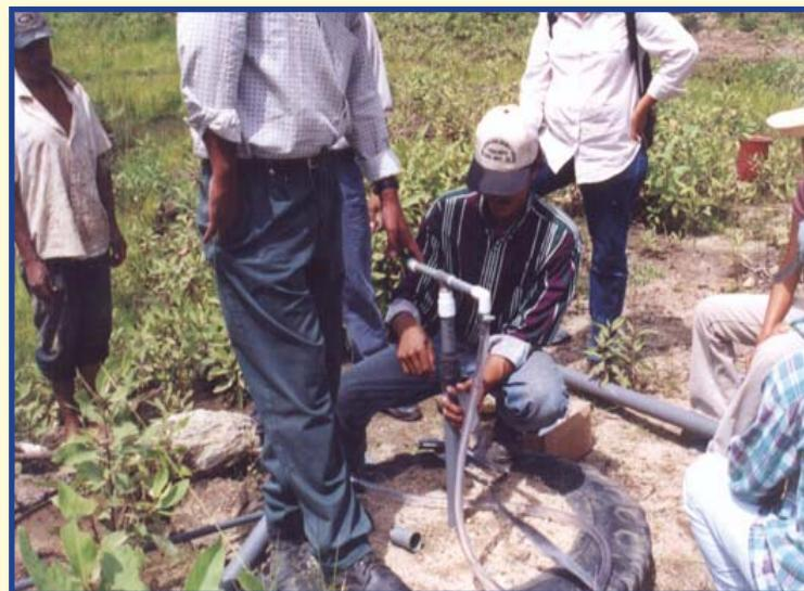
La primera bomba EMAS fue construida con válvulas de Pie y Pistón, las cuales ya han sido modificadas. Es por ello que a las que funcionan actualmente se les llama válvulas Scheck con maule en el pistón y tubo de cilindro, los cuales se fabrican de adaptadores macho y hembra con rosca de 1/2 plg y con una goma de hule neolay, cuero de lomo de res curado con aceite de oliva o cualquier otro material que sirva.
