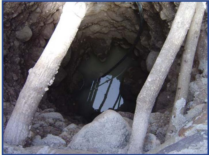
Se pueden excavar pozos con diámetros desde 1 a 4 mts, según la capacidad de la fuente subterránea. Su profundidad depende de la profundidad a que se encuentra la vena de agua.
