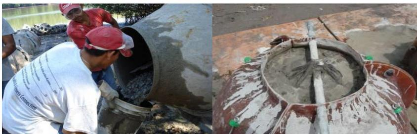
Fig. 11. Llenado de los moldes con la mezcla de concreto.
